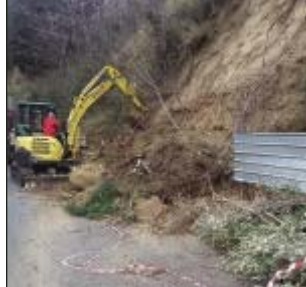
L'intervento a Rende sulla frana
