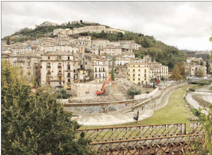
Il centro storico di Cosenza e il Jolly demolito
