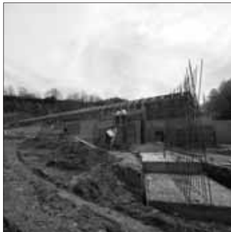
I lavori per la realizzazione della piscina
