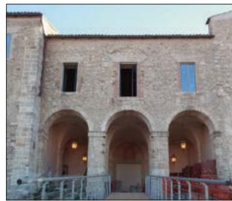
Il castello svevo a restauro ultimato
