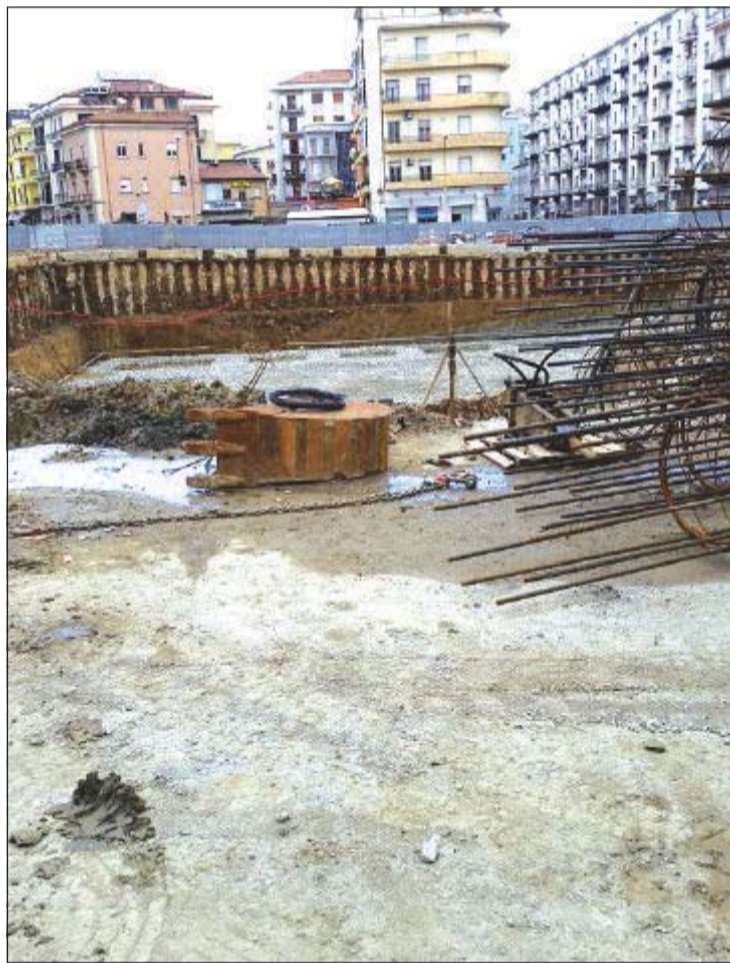
Lo stato dei lavori a Piazza Bilotti
