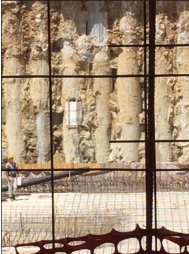
Alcuni dei pali in calcestruzzo finiti nel mirino dei consiglieri
