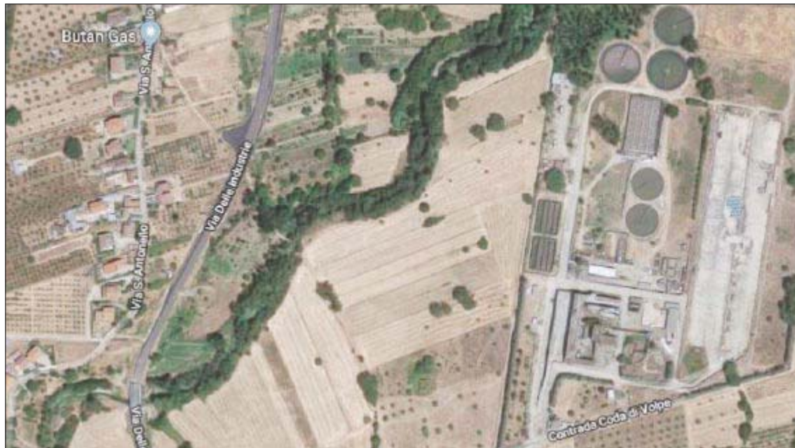
Il depuratore di contrada Coda di Volpe
